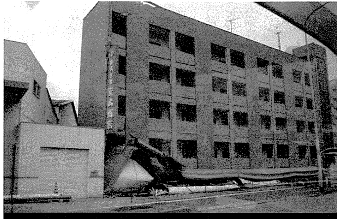
1階がつぶれてしまった5階建てのビル
